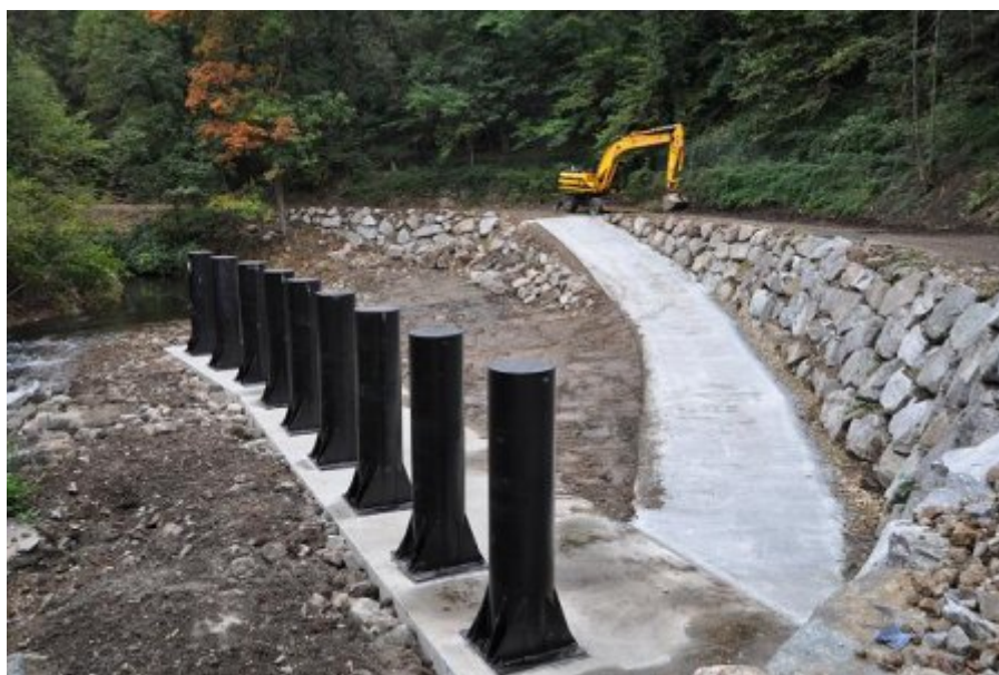
Figure 20 : Exemple de piège à embâcle
