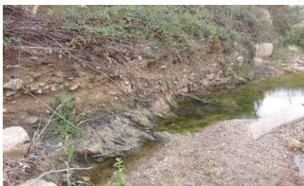
Figure 11 : Parcours d'amont en aval de la berge rive droite entre les 2 ponts
