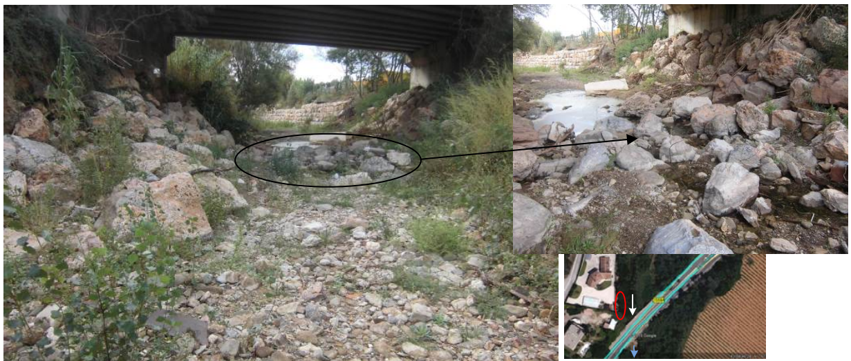
Figure 10 : Vue vers l'aval du pont RD559A
