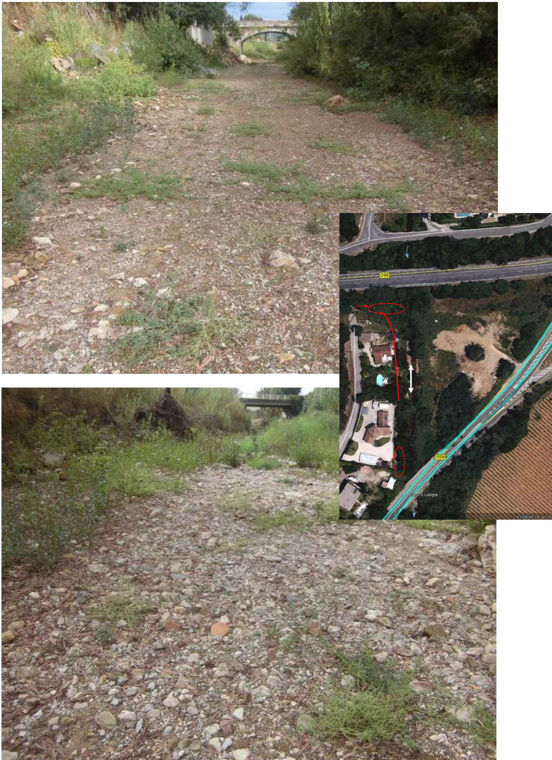
Figure 7 : Le Maravenne vu de l'aval (1 ère photo) et de l'amont (2 de photo) par temps sec
